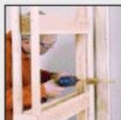
Крепление направляющих для лёгких конструкций
