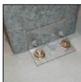
Крепление самонесущих конструкций
