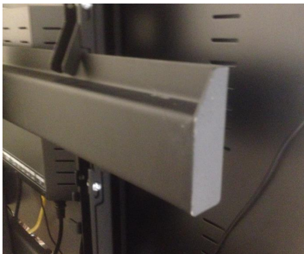
Рис. 2 Верхняя горизонтальная направляющая
