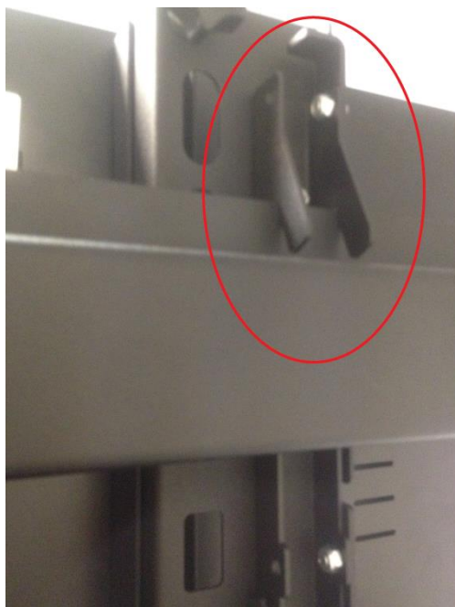
Рис.7 Навеска панели на верхнюю горизонтальную направляющую.
