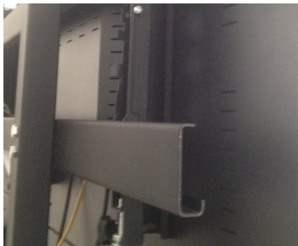
Рис.3 Нижняя горизонтальная направляющая
