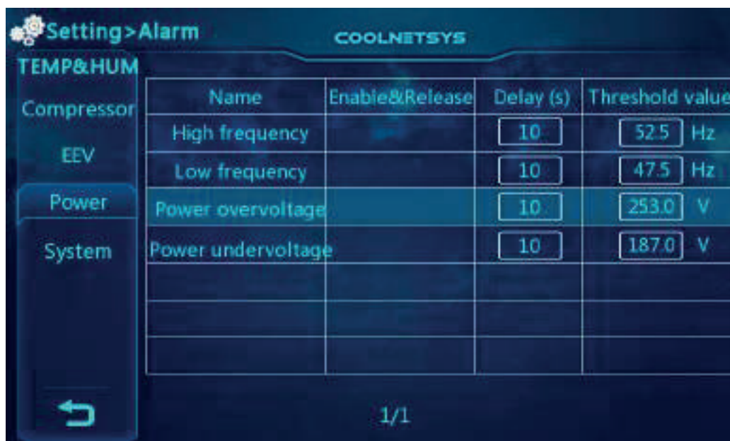
Рисунок 4-15 «Экран настройки аварийной сигнализации параметров питающей сети».
