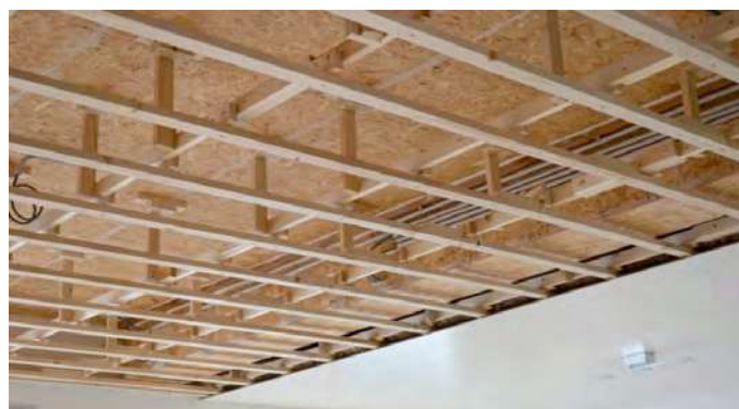
Деревянная обрешетка потолка
