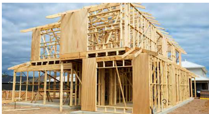
Каркасное строительство
