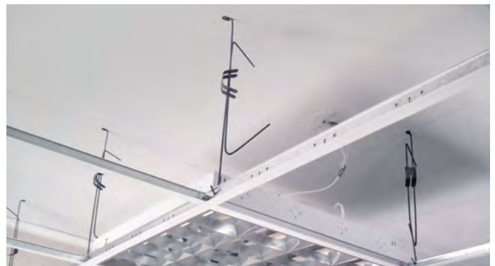
Монтаж подвесного потолка
