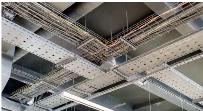
Монтаж кабельных лотков
