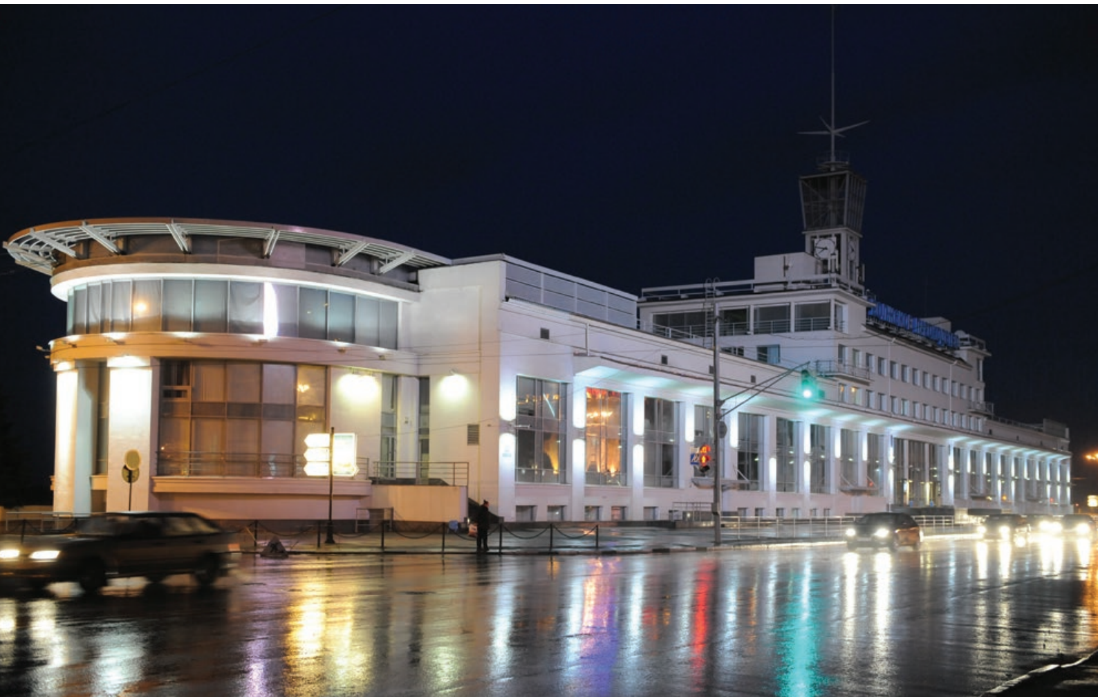
Внешняя подсветка фасада здания Волжского пароходства прожекторами серии Turtle LP-01
