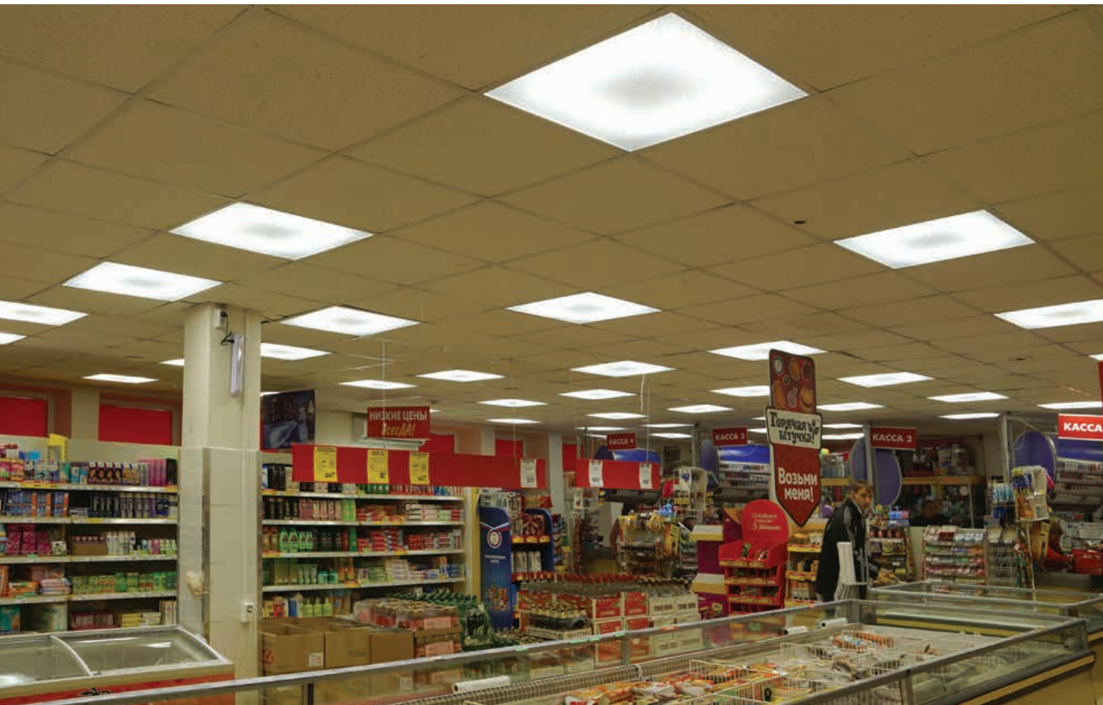
Освещение торгового зала светильниками серии АТ-СПВ-36-01
